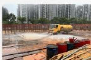
工地車行路面、堆料棄土區、傾斜作業區與裸露地面實施定時灑水噴霧，抑制揚塵產生。
